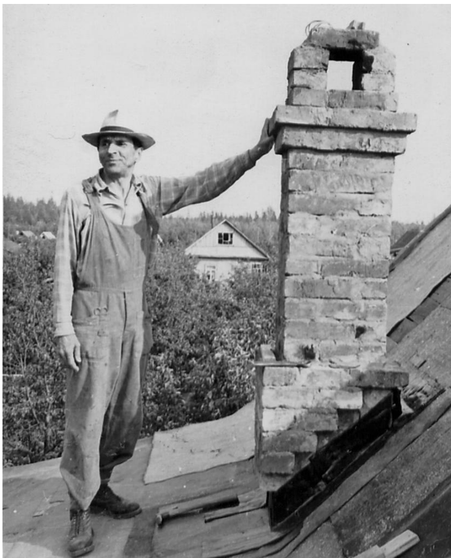
«Развитой социализм»: ремонт крыши халупы в Алабушеве хозспособом
