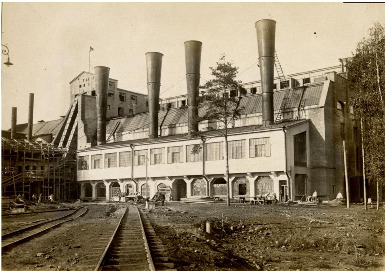
Вид станции со стороны котельного отделения, 1929 г. (фото с сайта www.mosenergo-museum.ru )
