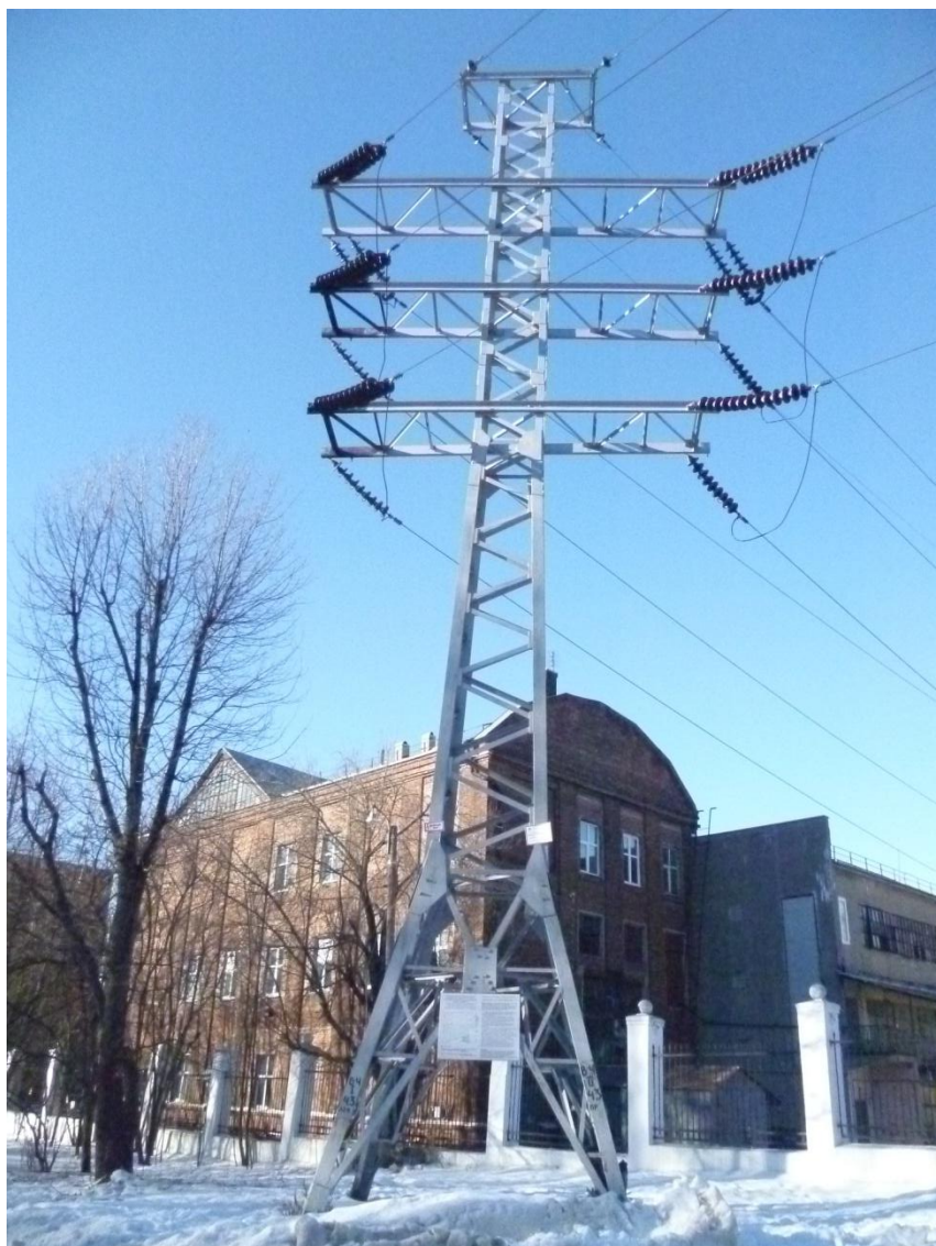
Историческое здание подстанции в Измайловском парке (теперь от Электрогорска к нему подходят современные ЛЭП напряжением 110 киловольт, зима)
