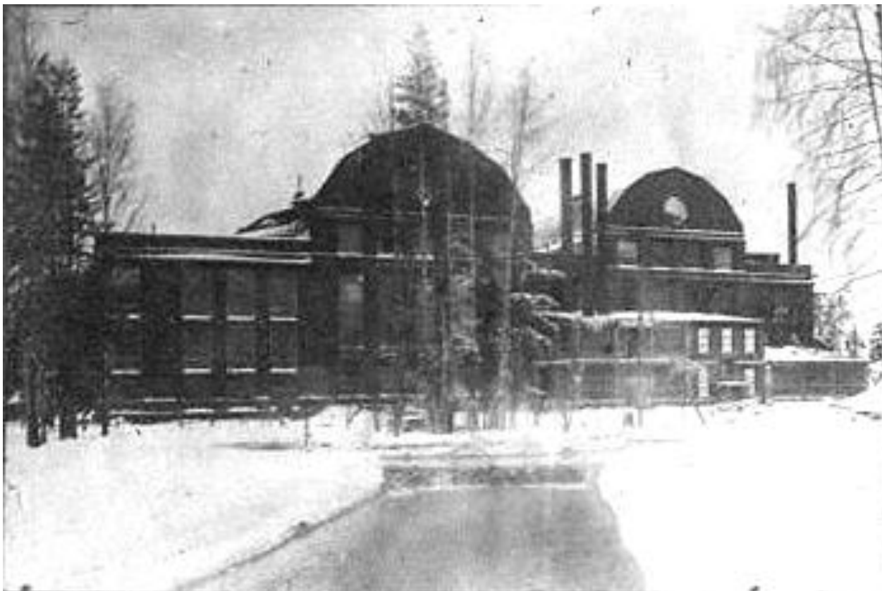
«Электропередача» до расширения мощности
