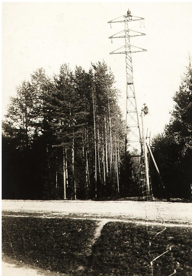
Монтаж изоляторов и проводов ЛЭП напряжением 70 киловольт, 1914 г.
